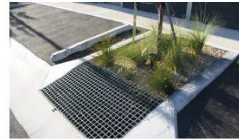
Abb 26 Einleitung wenig belasteter Straßenabflüsse in Pflanzgrube
