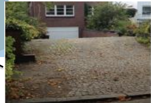
Schwelle vor Garageneinfahrt
