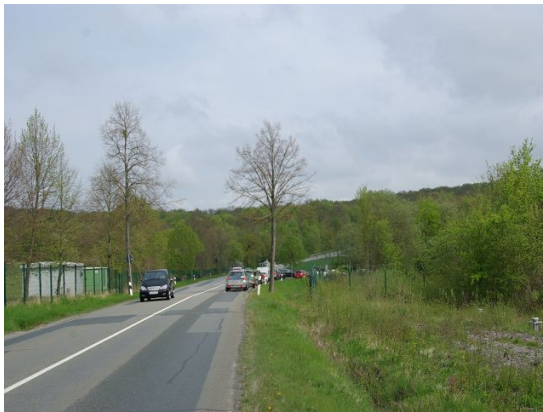
Blick von Süden auf Einmündungsbereich
