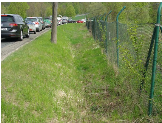
Der Graben wird nach Osten verlegt
